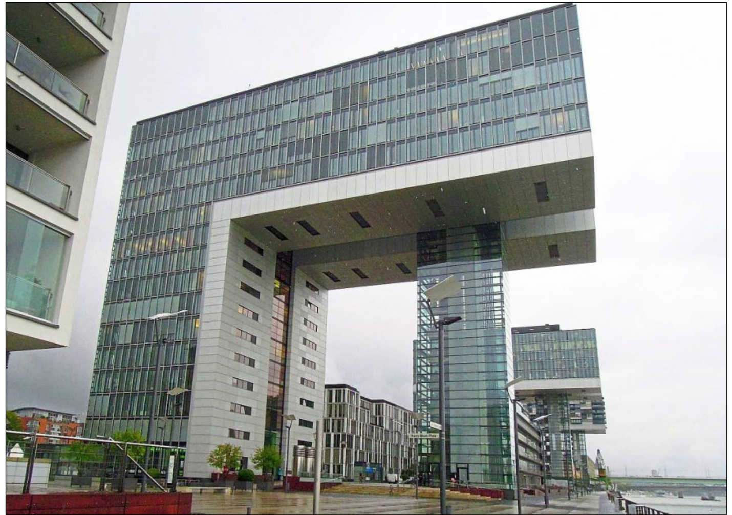
DIE KRANHÄUSER in Köln gehören zu den spektakulärsten Entwürfen von Hadi Teherani. Die drei mehr als 60 Meter hohen Türme, die an die Form von Lastkränen anknüpfen, wurden 2010 auf dem Gelände des alten Rheinauhafens vollendet. Foto: Ulrich Coenen
