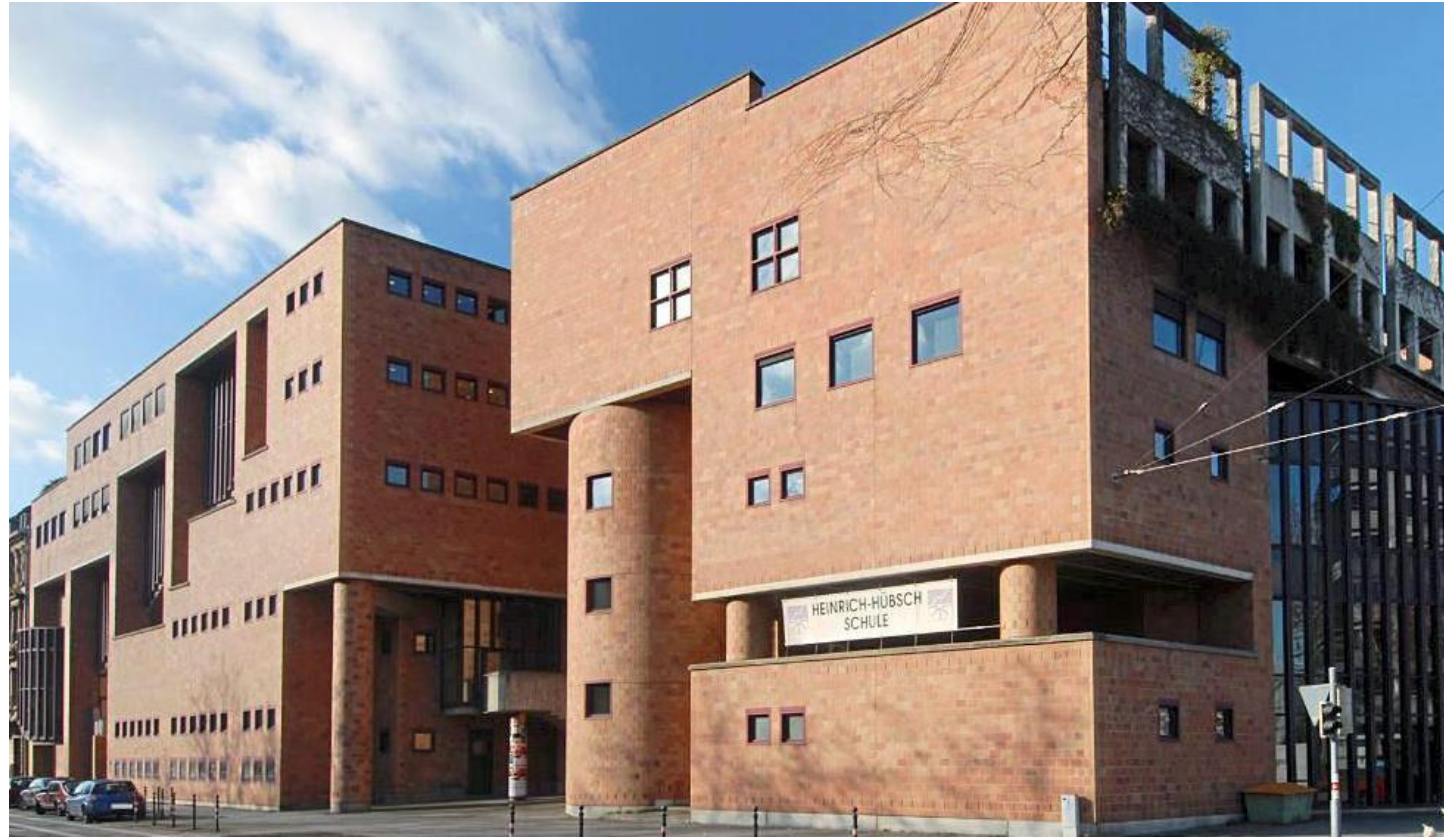
Heinz Mohl spielt mit Motiven aus der Architekturgeschichte. Die Heinrich-Hübsch-Schule in Karlsruhe besteht aus verschiedenen Baukörpern, die der Architekt mit Stegen verbunden hat. Foto: Stadt Karlsruhe
