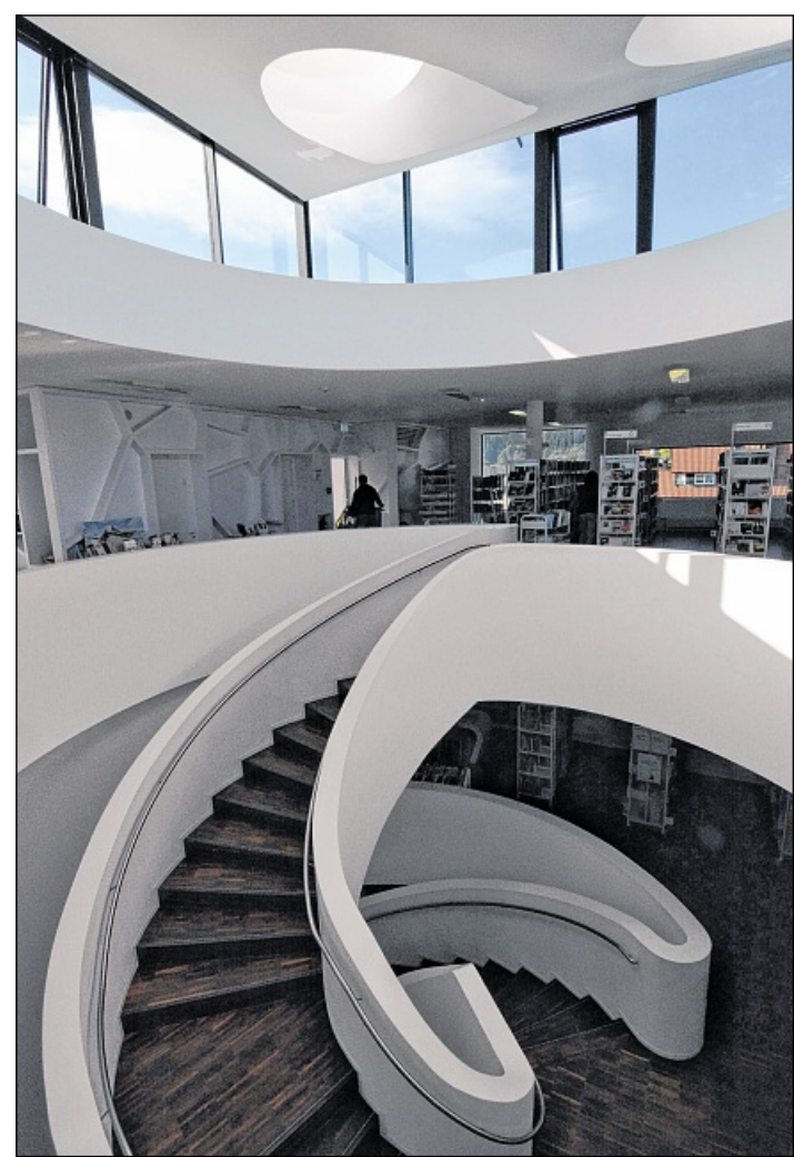
ORGANISCHE FORMEN: Die Treppe der Mediathek hat die Form einer Spirale und erschließt alle drei Geschosse des Gebäudes.
