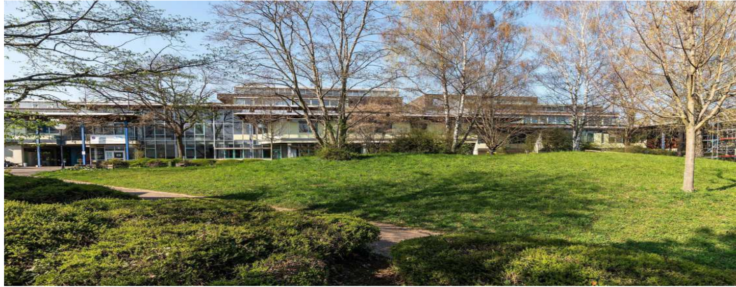
Bauplatz im Garten: An dieser Stelle vor dem Hauptgebäude der Robert-Schuman-Schule in Baden-Baden ist der Erweiterungsbau geplant. Die Stadt lobt einen Realisierungswettbewerb aus. Foto: Ulrich Coenen
