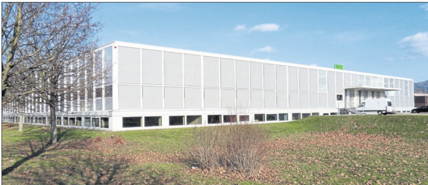
DAS USM-FIRMENGEBÄUDE in der Siemensstraße in Bühl entstand 1983 bis 1992 in drei Bauabschnitten in dem von Fritz Haller entwickelten Stahlbausystem Maxi. In Deutschland ist es einzigartig. Fotos: Coenen
